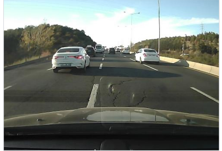
Araç kamerasından alınan gerçek saha görüntüsü — sistem, yol yüzeyindeki bozulmayı araç hareket hâlindeyken tespit eder.
